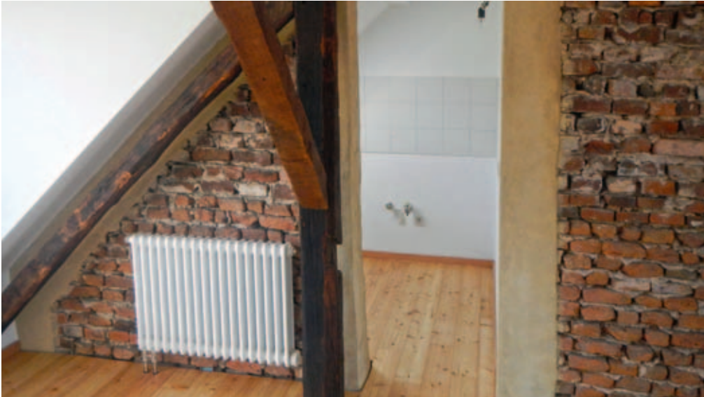
Wiederwendung alter Backsteine bei einem Dachausbau
