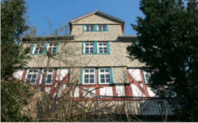
Beispiel einer Schindelverkleidung aus Nordhessen
