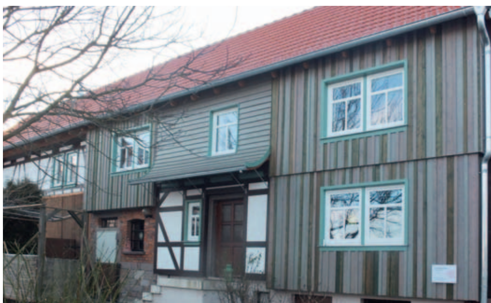
Größere Öffnungen zu Fensterpärchen umgebaut
