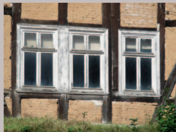
Fensterdrilling an einem barocken Fachwerkhaus
