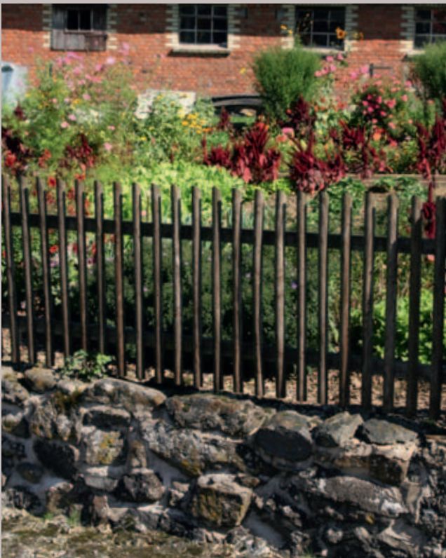
Lattenzaun auf Bruchsteinmauer
