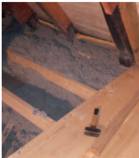
Aufdeckendämmung mit Nut und Federabdeckung.
