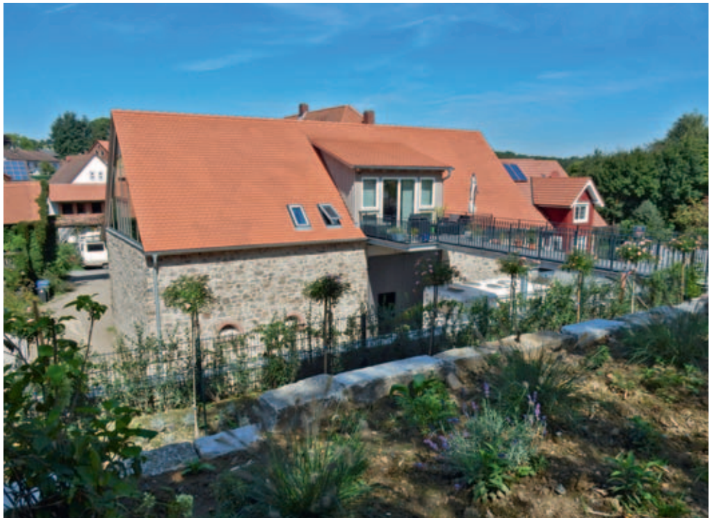
Gartenanlage hinter einer umgebauten Scheune im Odenwald
