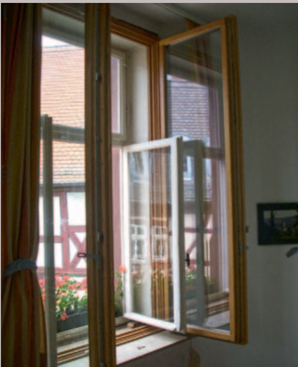
Stulp-Innenfenster hinter historischem Fenster
